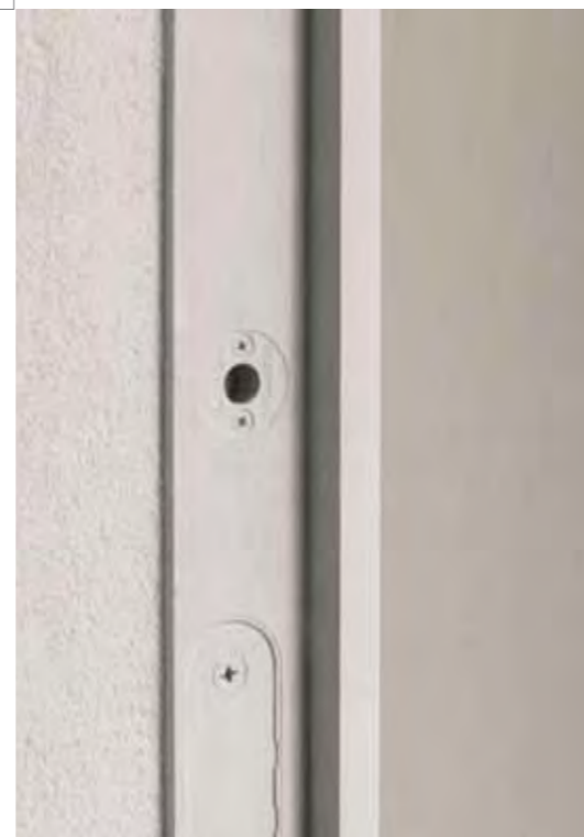
Porta resistente al fuoco particolare dei rostri presenti sul nucleo telaio.
